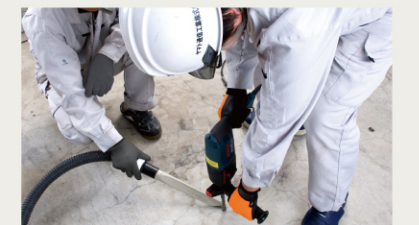
現地調査/アンカー工事/フリーアクセス加工など 幅広い対応が可能です
